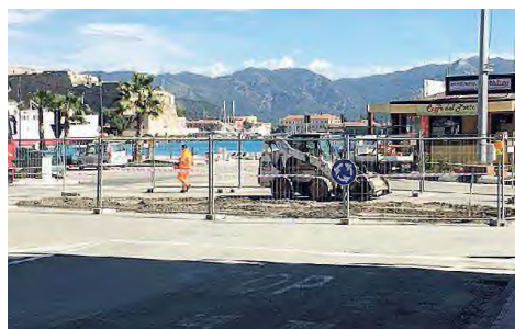
Lavori iniziati per la realizzazione della rotatoria
