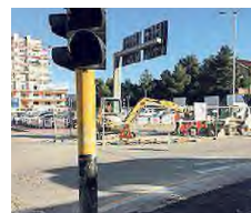
Lavori in via Zambelli
